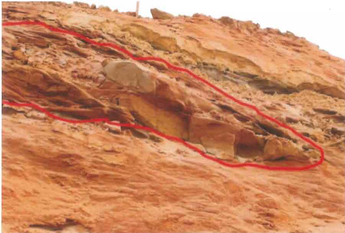
Banc de quartzite fragmenté inséré entre une poche d'argile au-dessus et un banc de sable au-dessous
