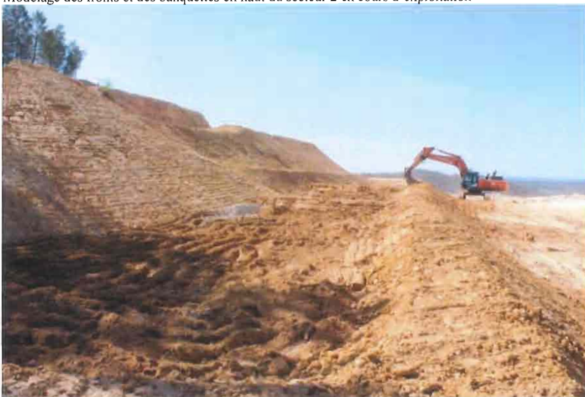
Modelage des fronts et des banquettes en haut du secteur 2 en cours d'exploitation
